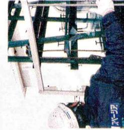
スペーザリアは一枚ガラスの約4倍の断熱性能。
